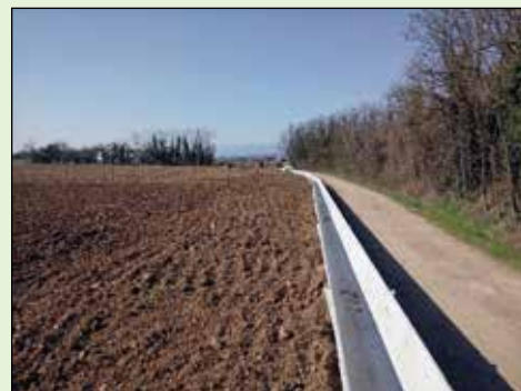
Sostituzione canalette ammalorate
