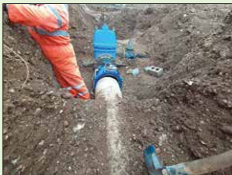
Sostituzione saracinesche vetuste
