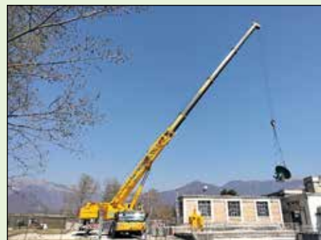
Manutenzione centrale idroelettrica a Fener
