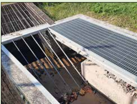
Pulizia di una delle griglie presenti nel territorio in collaborazione con Contarina
