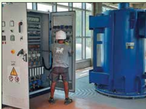
Manutenzione idrovora Portesine a Roncade
