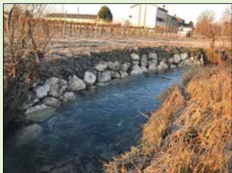
Ripristino frane lungo la Piavesella di Colfosco, località Rai di San Polo di Piave
