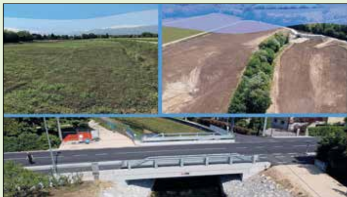
Messa in sicurezza torrente Codolo con realizzazione di due casse di espansione a San Fior e rifacimento del ponte a Codogné
