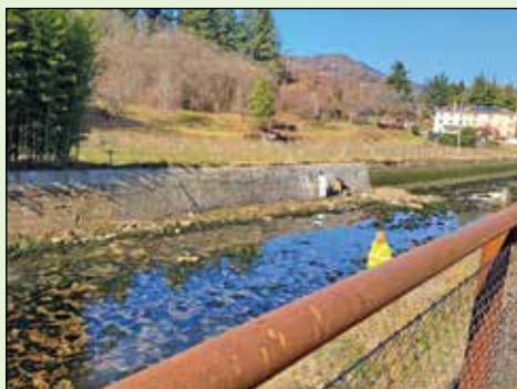
Risanamento muro di sponda Canale Brentella a Pederobba
