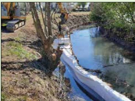
Ripristino frane lungo il canale Nerbon a Silea
