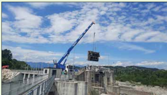
Sostituzione paratoie Galileo all'opera di presa di Nervesa della Battaglia (TV)
