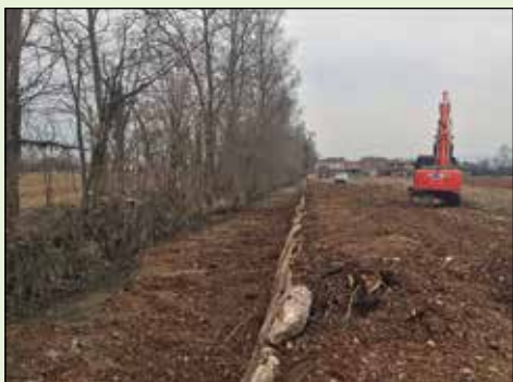
Consolidamento sponda con rocce in area irrigua (nella foto il t. Brenton)
