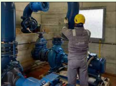
Manutenzione stazioni di pompaggio irriguo
