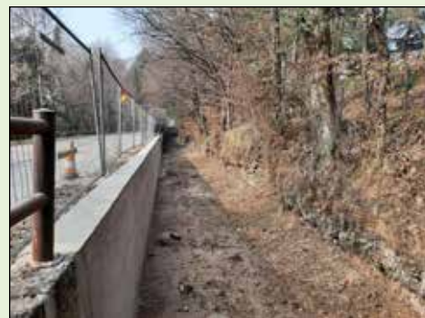
Rifacimento tratto di muro di sponda del Canale del Bosco a Montebelluna
