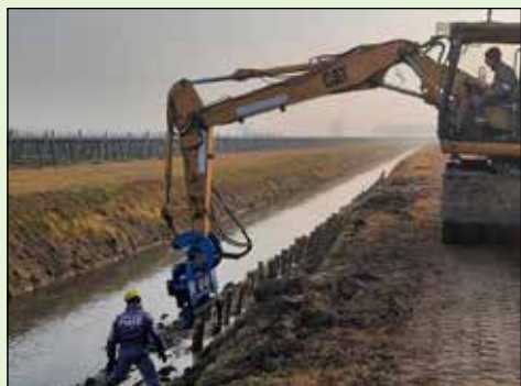
Ripristino frane lungo canale Peressina
