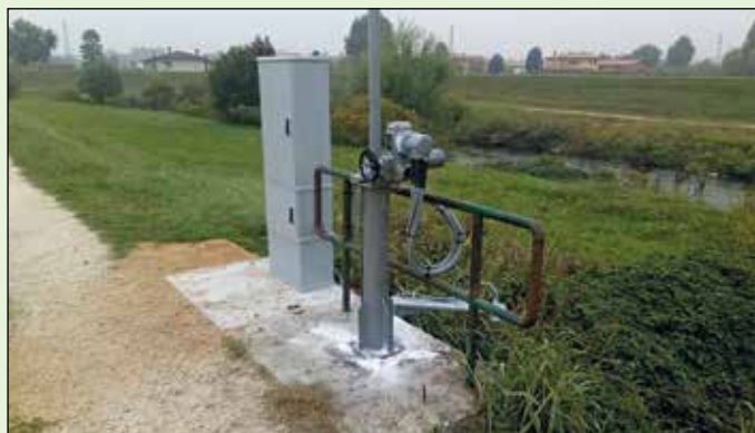
Automazione chiaviche sul fiume Monticano
